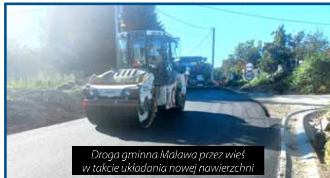
Droga gminna Strażów „Skotnik” na końcowym etapie robót
